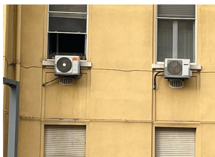
Serie di unità esterne di condizionatori d'aria posizionate, in un edificio pubblico, sotto le finestre delle camere dei degenti e/o degli uffici.
