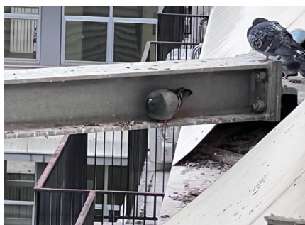
Strutture in acciaio per il contenimento sismico di un edificio ospedaliero colonizzate da piccioni.
